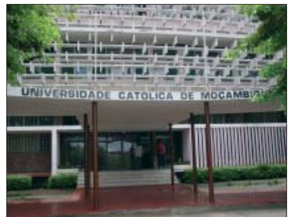
Figuur 1. De voorgevel van het faculteitsgebouw, dat gelukkig goed wordt onderhouden.
